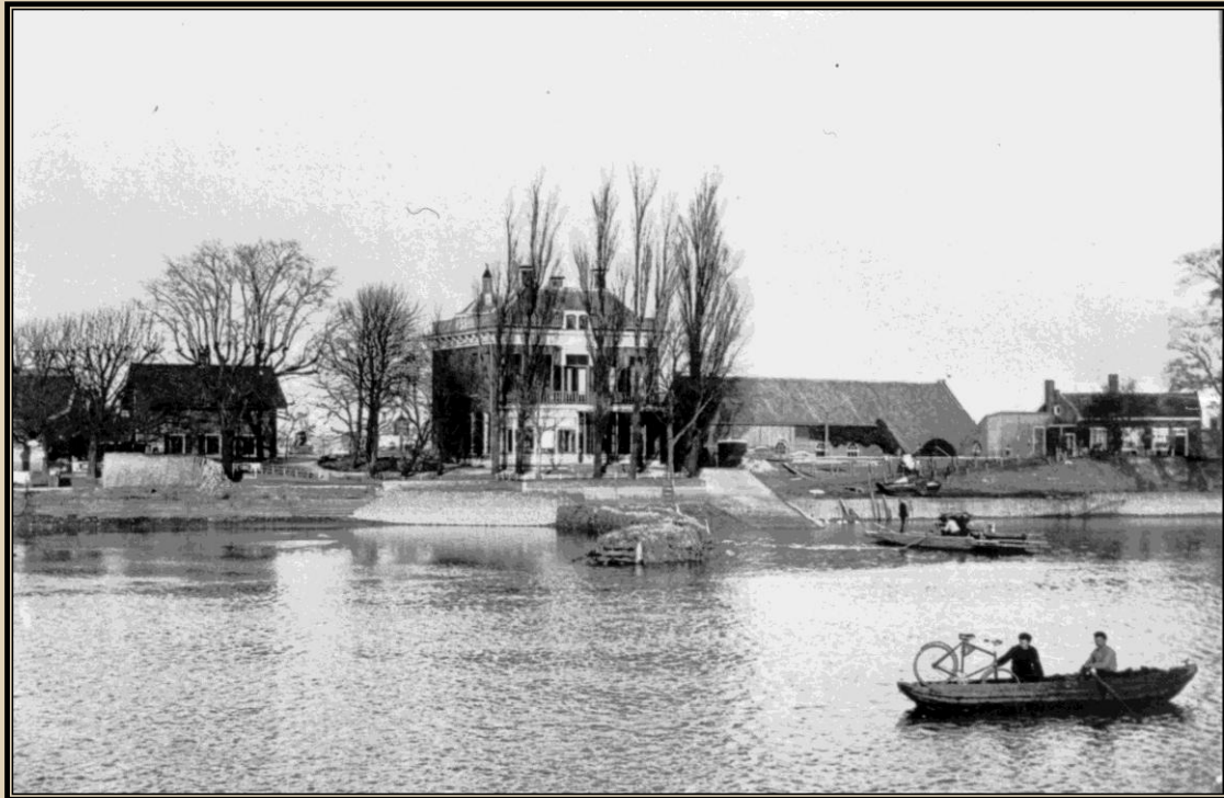
Woonhuis A. Mijnlieff met rechts van het midden de droogloods. Op de voorgrond de strekdam met het pontveer naar Nieuwerkerk a/d IJssel
