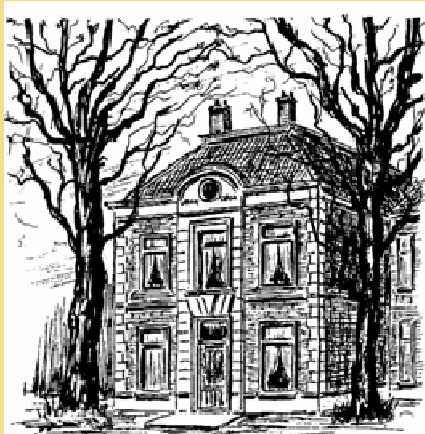
De villa 'Weltevreden', de woning van de directeur van steenfabriek Ouderzorg - De Ridder en Canton. In 1961 is het gehele fabriekscampus inclusief de villa gesloopt voor de nieuw te bouwen wijk Ouderzorg, gebouwd tussen 1962 en 1966.
