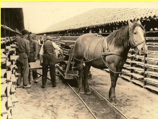
De vormen worden nog met behulp van paarden naar de baan de droogrekken gereden. Daar worden de vormen door afslagers met behulp van de afslagbok gelost op een droogplank.
