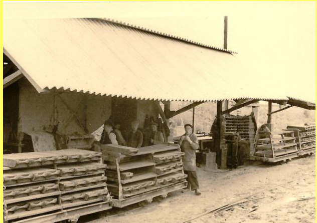
Het bedrijf produceert straatstenen, welke op twee veldpersen worden vervaardicht.
